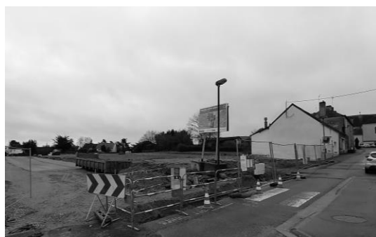
Site de la Perretterie en 2018 (source : Auddicé)
