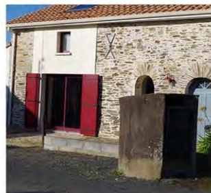
Puits proche de la parcelle 199
