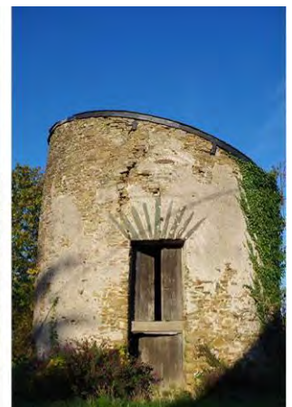
Moulin à vent situé à la Gagnerie sur la pc 100
