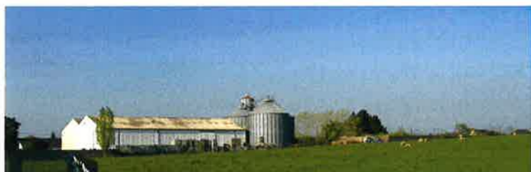
Le hangar et le silo de Terrena
