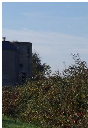
Moulin à vent à La Belière sur la pc 71
