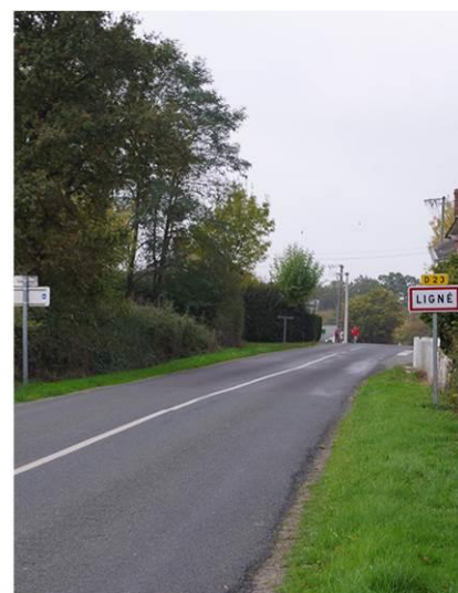
5 – Entrée Est par la D23 : un point de vigilance à avoir sur la traversée de la voie verte qui suit l'entrée. Des barrières en bois sur la voie verte permettent d'éviter des traversées trop rapides. La traversée sur enrobé de la voie verte gagnerait à être plus marquée par une peinture au sol.
