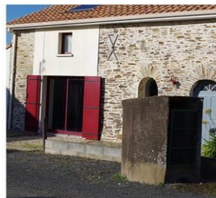
Puits proche de la parcelle 199
