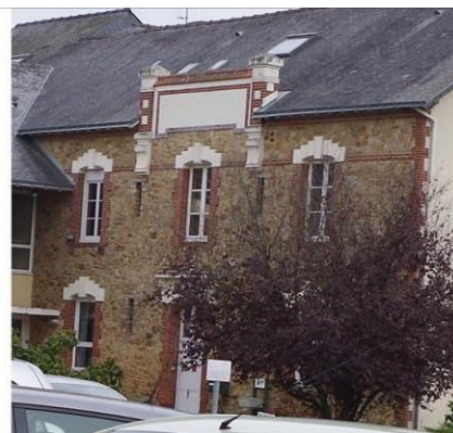
Ancienne gare puis ancienne gendarmerie devenue l'actuelle maison de retraite. Parcelle 111.
